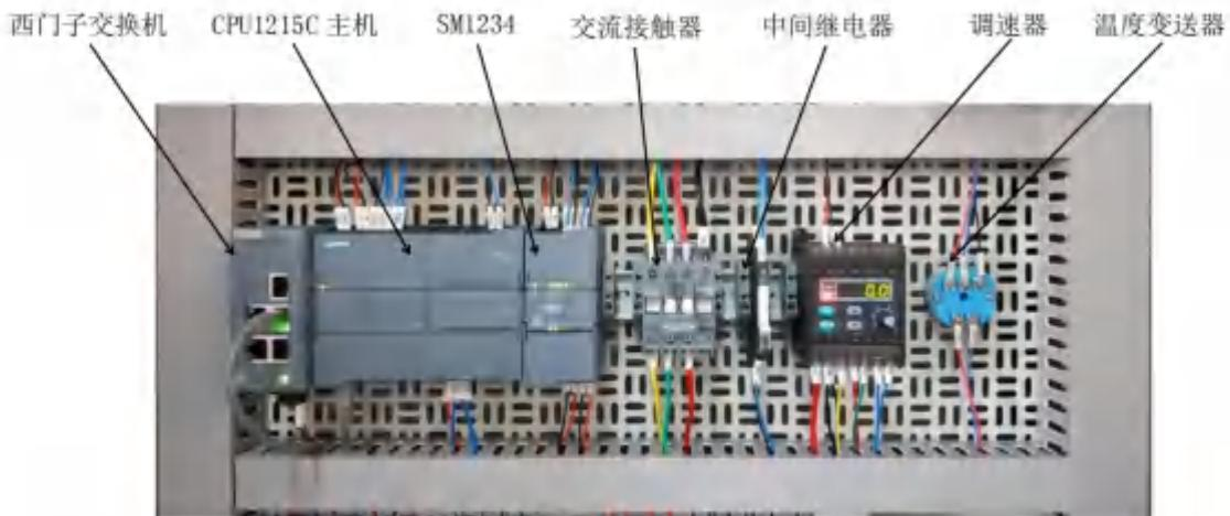
控制系统组件主要包括西门子工业以太网交换机、CPU1215C PLC 主机、SM1234 模拟量输入/输出模块、交流接触器、中间继电器、调速器、温度变送器等。
